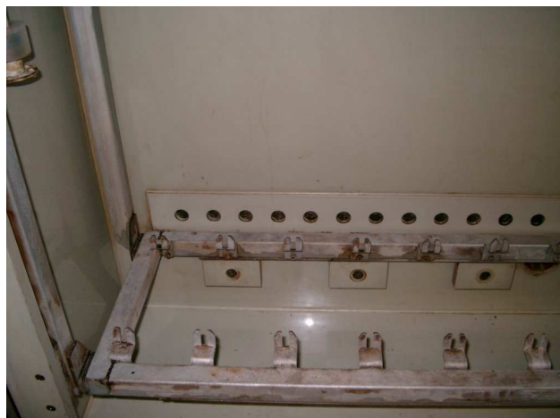
Abb. 13: Edelstahlgestell im Abscheidraum von Modul I der Laboranlage
